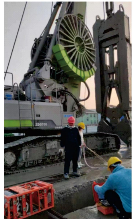
绍兴轨道交通二号线项目 Shaoxing Rail Transit Line 2 Project
